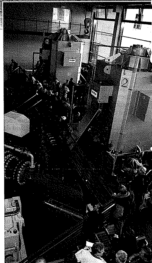
Die Turbinen produzieren pro Jahr rund 64 Millionen Kilowattstunden elektrischen Strom. Das entspricht in etwa dem durchschnittlichen Jahresverbrauch von 16.000 Familien. rewe
