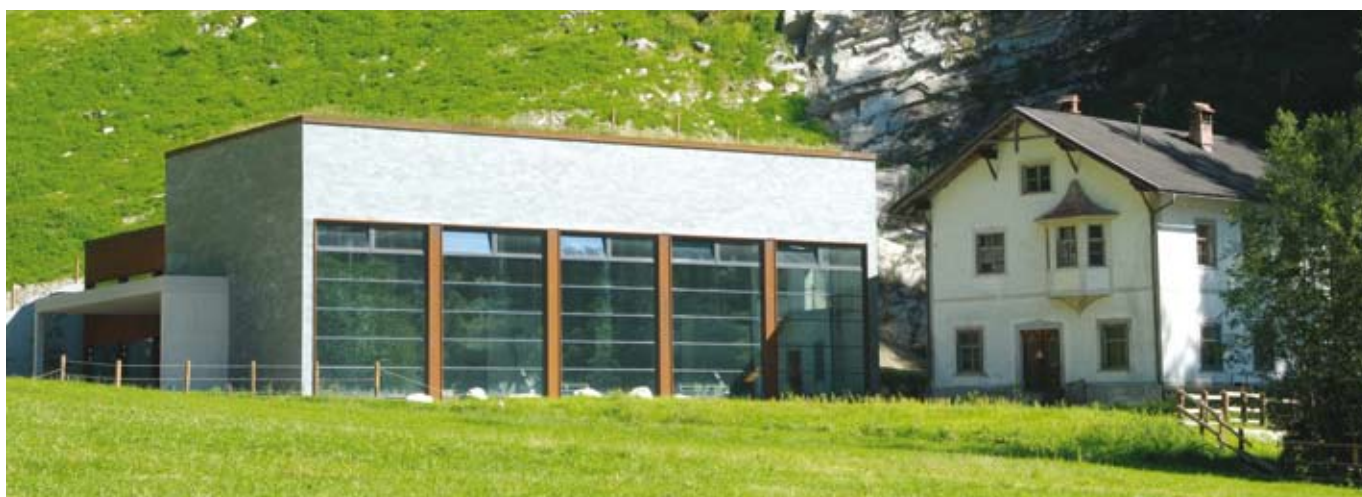
Centrale idroelettrica, Campo Tures (BZ)
